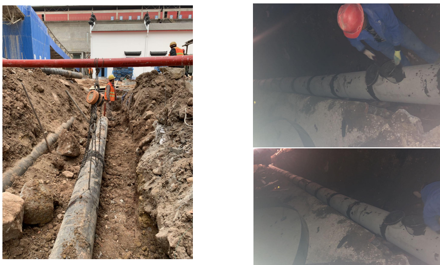
应急事故池暗管铺设图片
